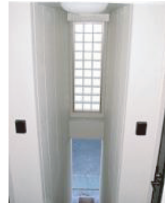
階段上部のガラスブロックから 明るい光が差し込む
